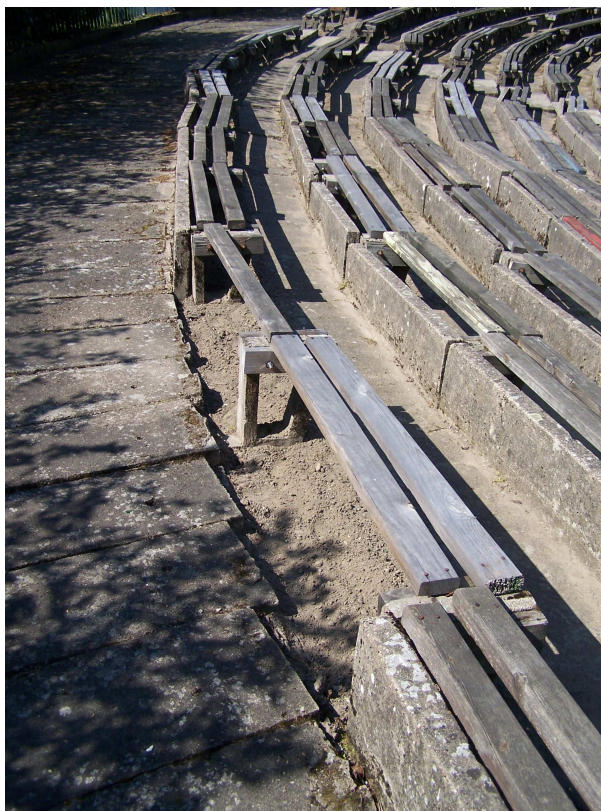
Fot. 3.3. Nawierzchnia komunikacji i dewastacja ławek na koronie amfiteatru
