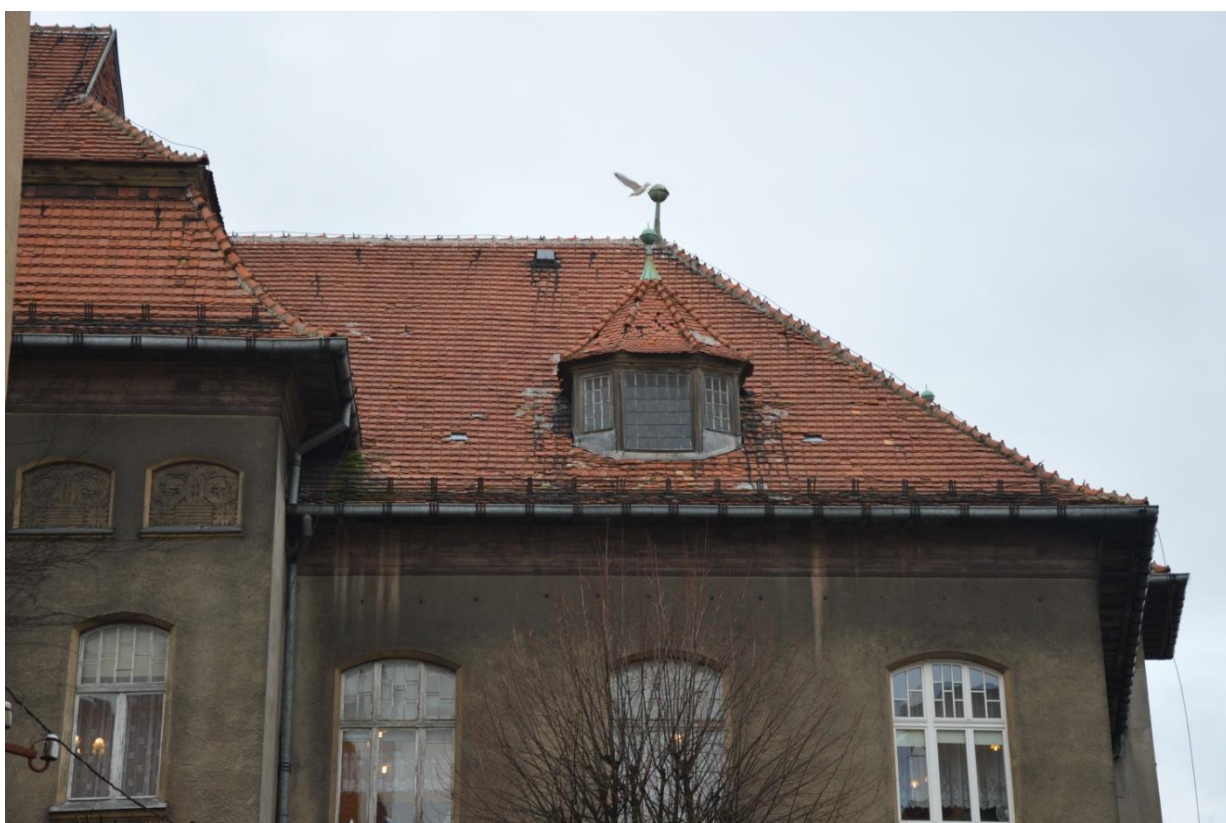
Fot.4 Fragment elewacji frontowej wschodniej – ubytki w pokryciu dachowym.
