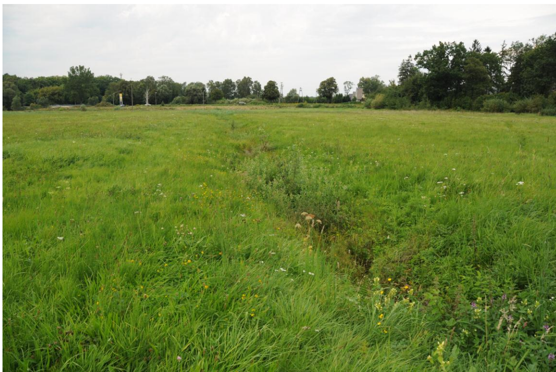
Fot. 9. Rów odwadniający w miejscu projektowanej inwestycji
