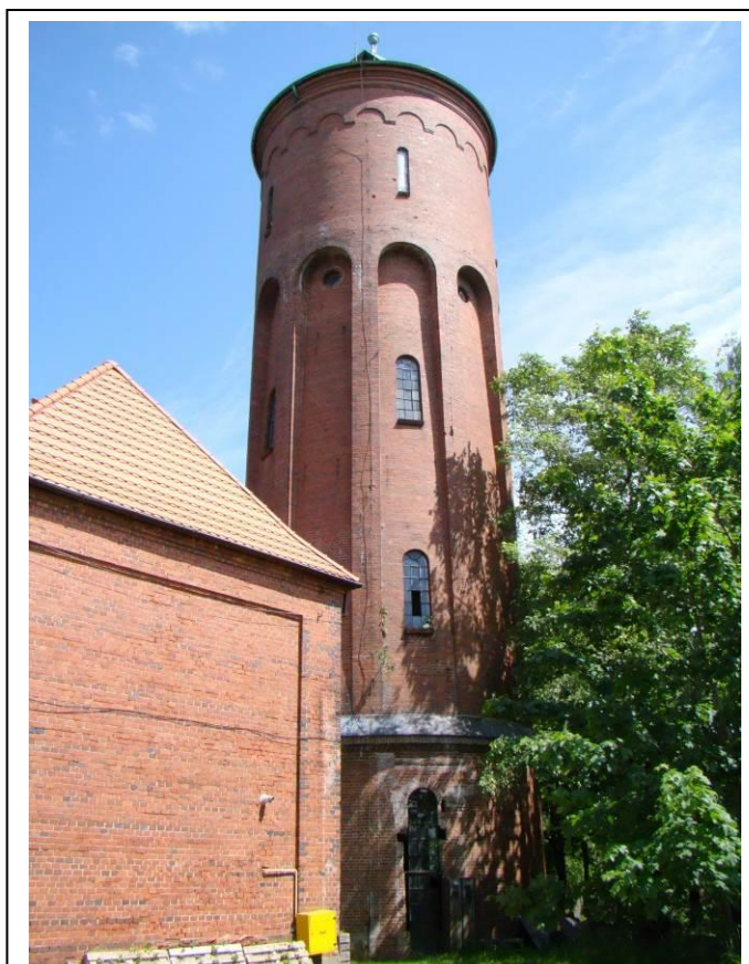
Wieża ciśnień, 1927 r. – ul. Koszalińska 23A
