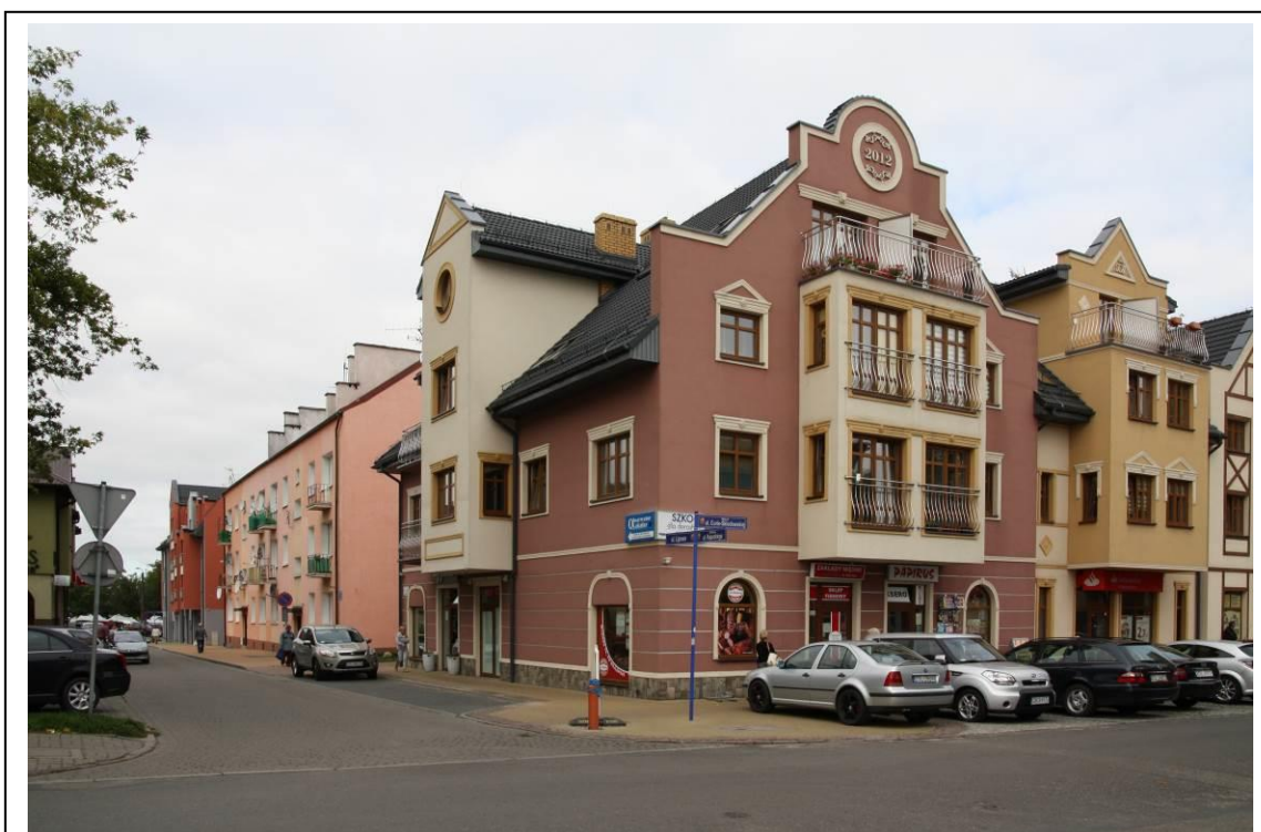
Nowa zabudowa - ul. Lipowa / Skłodowskiej
