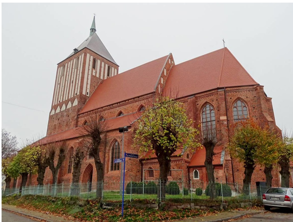
Kościół farny p.w. Wniebowzięcia NMP
