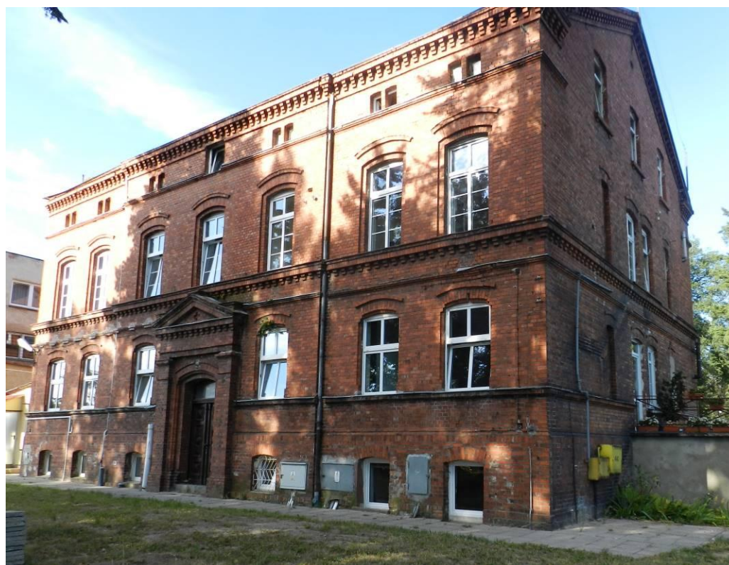
Szpital / dom starców, obecnie Szpital Powiatowy, Ul. I Pułku Ułanów
